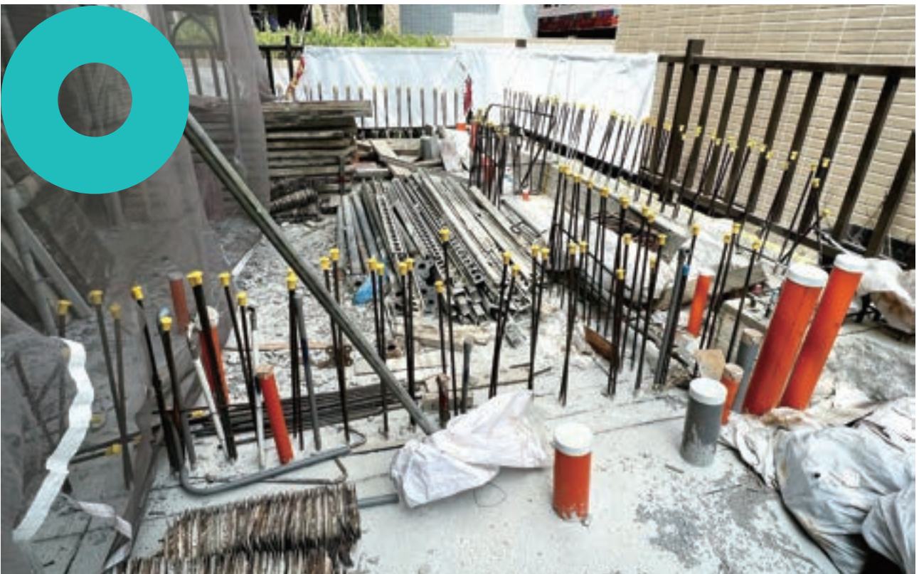
圖 42 暴露鋼筋加護套方式防護
