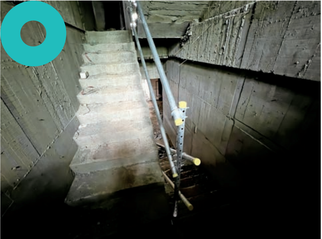
圖 20 構造物樓梯已設護欄（可再加立柱及增設垂直安全網）
