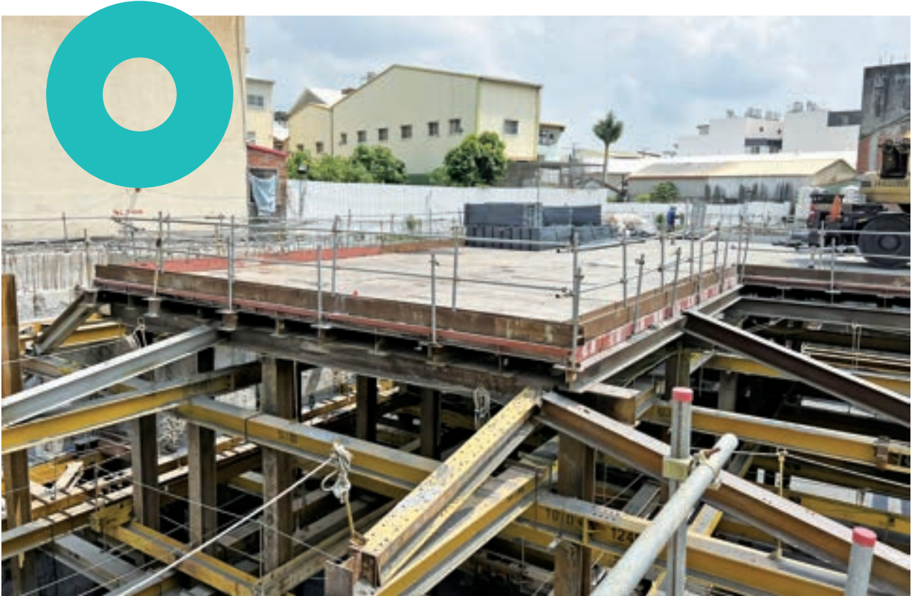
圖 12 高差 2 公尺以上施工構台開口邊緣已設置護欄（改善例）
