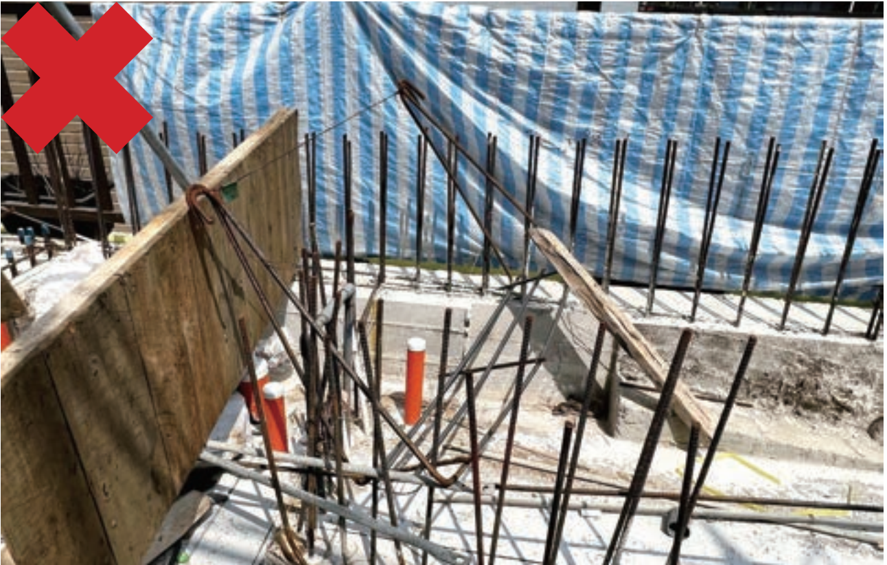
圖 41 工地現場暴露之鋼筋
