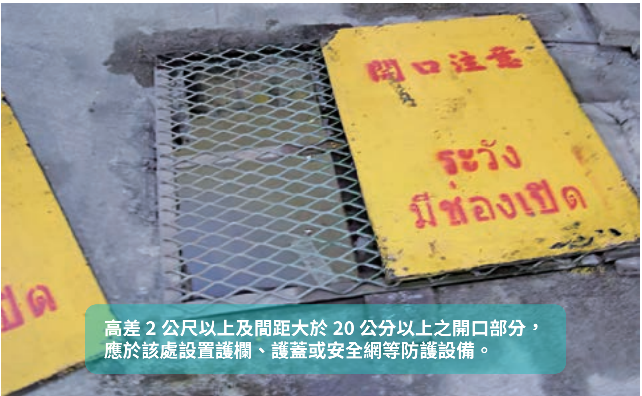
圖 13 地面開口設置護蓋及隔柵
