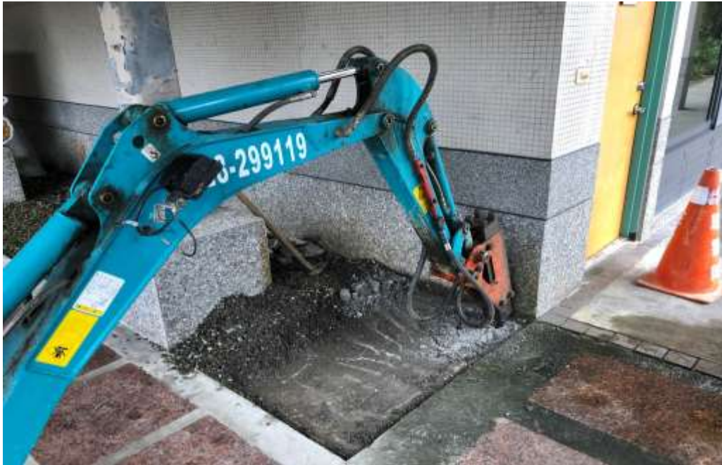
環解中心查漏水-1
