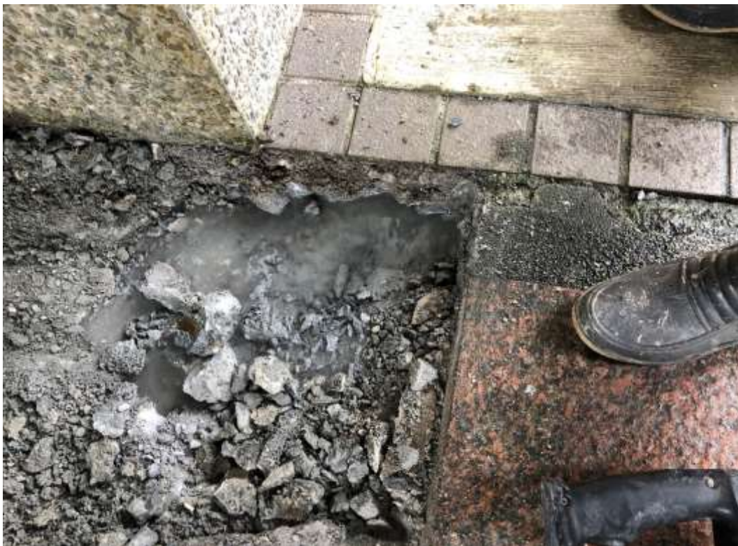
環解中心查漏水-2
